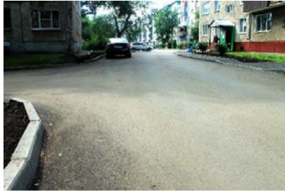
Ремонт дворовых проездов
