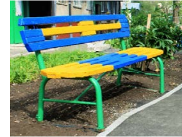
Установка скамеек, урн
